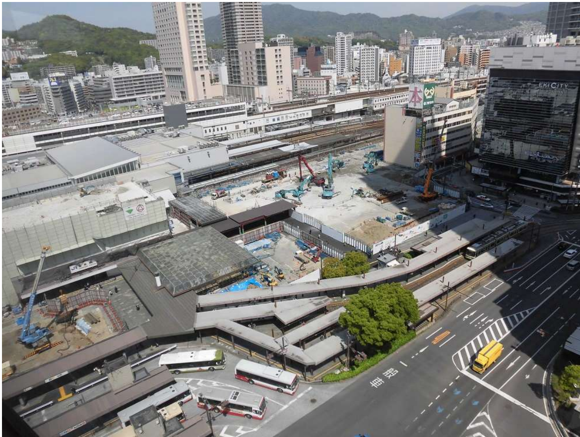
■広島駅南口。現在大規模な建替え工事が行われている。
