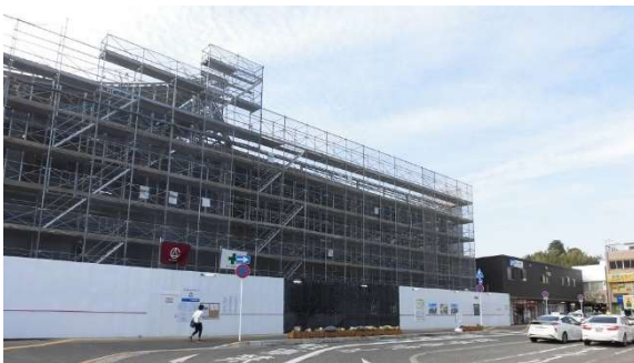
■建設中の「西広島駅」南口。
